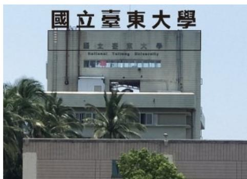
(二)「國立臺東大學」8尺\*8尺鋁板烤漆沖孔LED立體字設置於屋突牆面
